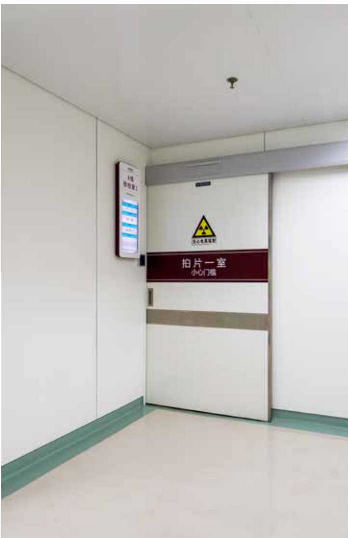
墙面板密封胶填缝，转角为爱克威盛亚阳角板材
