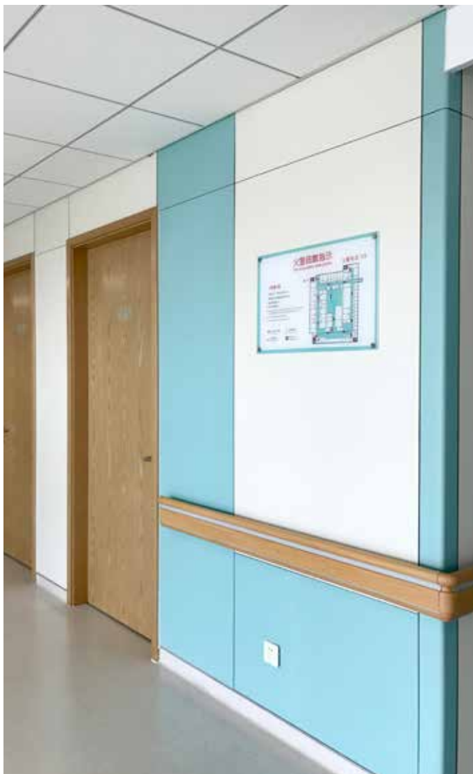
墙面板密封胶填缝，转角为爱克威盛亚阳角板材
