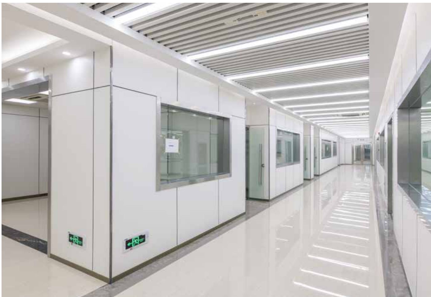
墙面板密封胶填缝 / 金属装饰条
